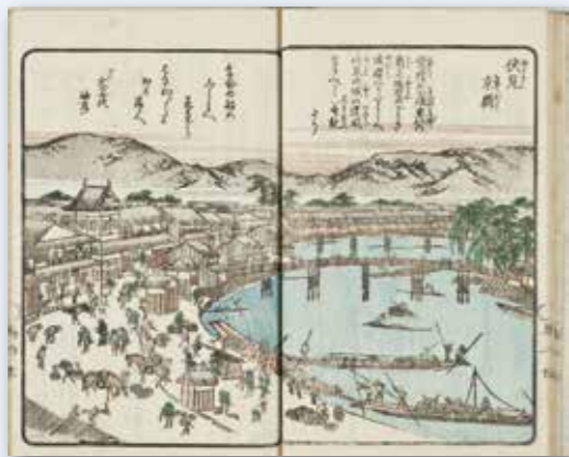
伏見・京橋の様子(『淀川兩岸一覽』、京都学・歴史館、京の記憶アーカイブより)
